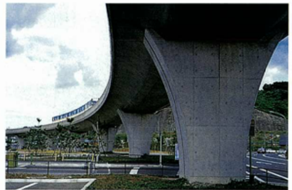
写真 3-1 分割施工法の施工例
