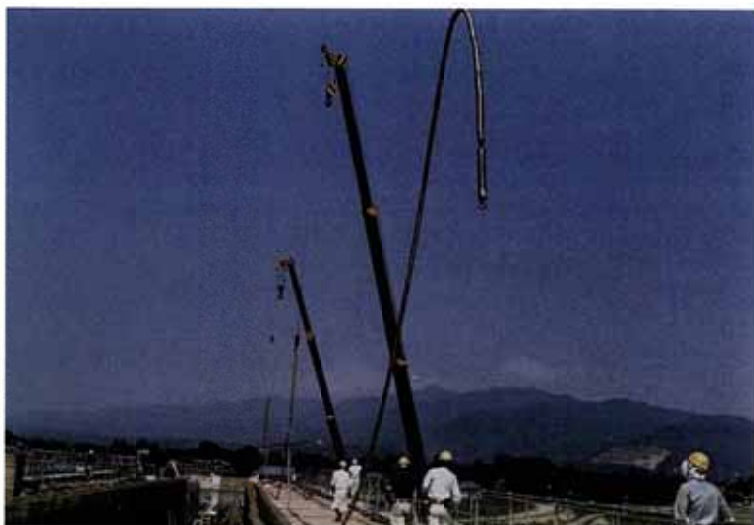
写真 1-9 レッカーによる吊上げ
