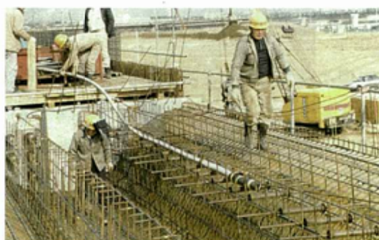
写真 1-2 ローラーによる引出し配線
