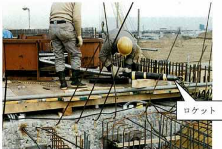
写真 1-6 引出治具（ロケット）の取付け
