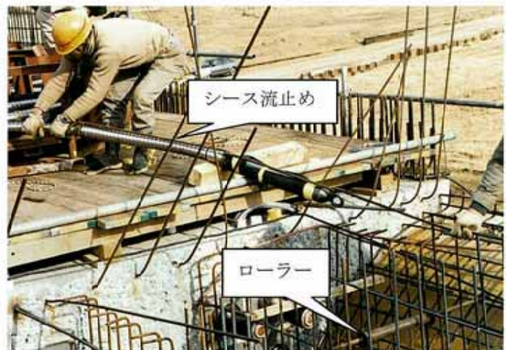
写真 1-7 シース流止めの取付け
