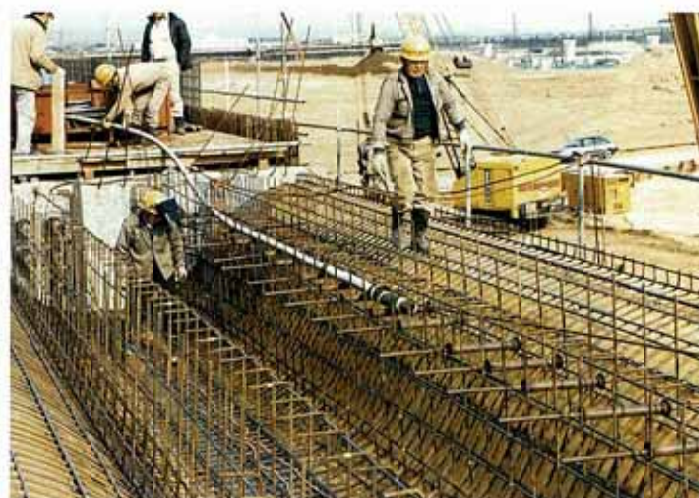
写真 1-8 ケーブルの引出し
