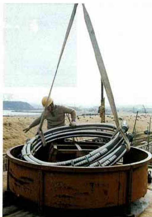
写真 1-4 リール台への吊込み
