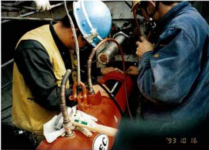
写真 2-4 緊張作業、伸び量の測定
