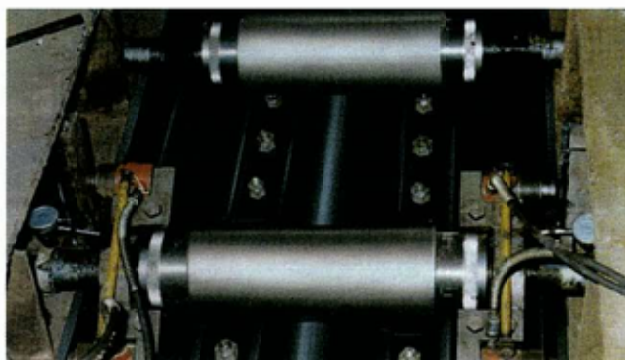
写真 4-1 耐震連結装置取付け状況
