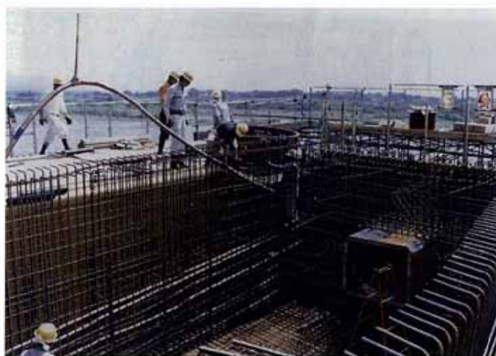
写真 1-11 ケーブル端部の配置
