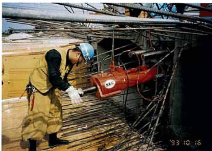
写真 2-3 止めナットのセット
