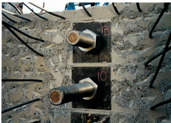
写真 2-1 緊張後伸びが出た状態(2 段目)の緊張端
