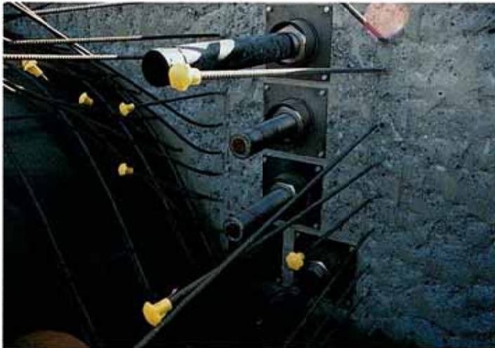
写真 2-7 緊張済みケーブル カブラーシースのベースのセット
