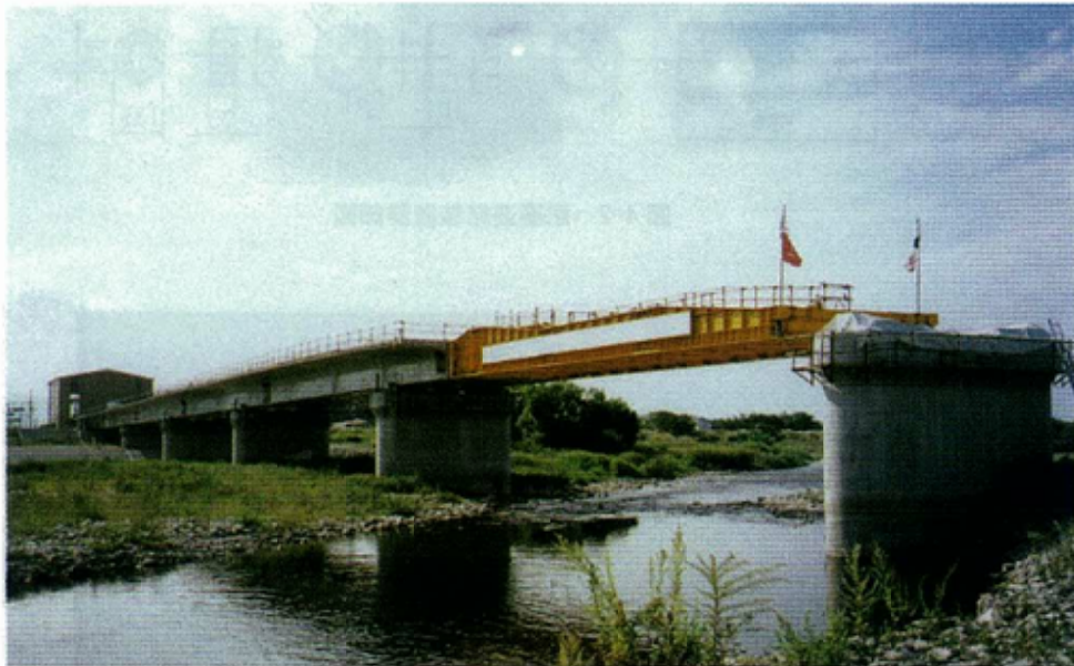
写真 3-3 押し出し工法の施工例
