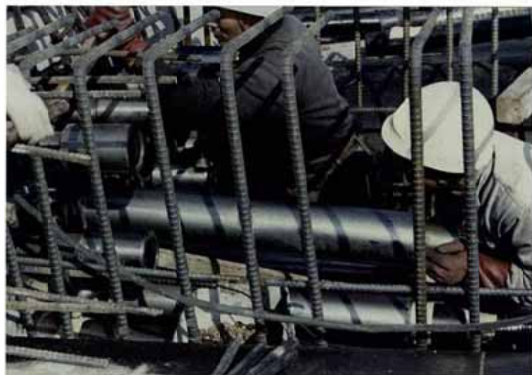
写真 2-11 カブラーシースの取付け
