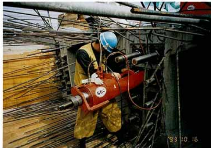
写真 2-5 定着ナットの締付け
