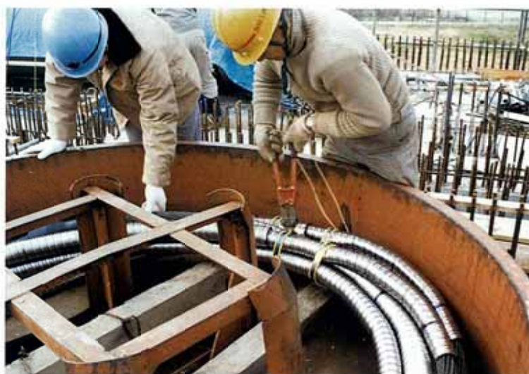
写真 1-5 ケーブル束ねの切断
