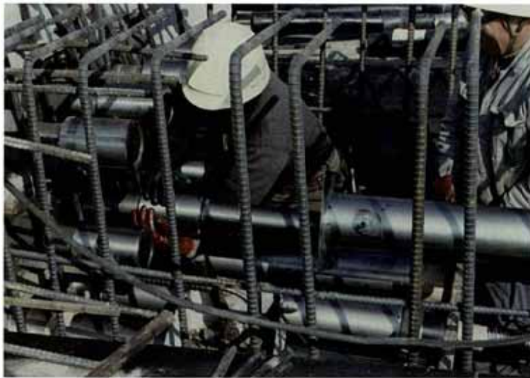
写真 2-10 カブラーを巻き戻して接続
