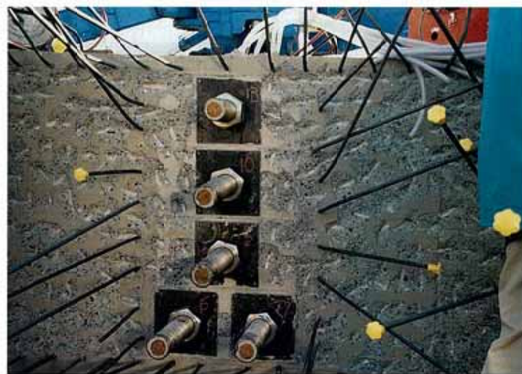
写真 2-6 緊張端の状況 F 200
